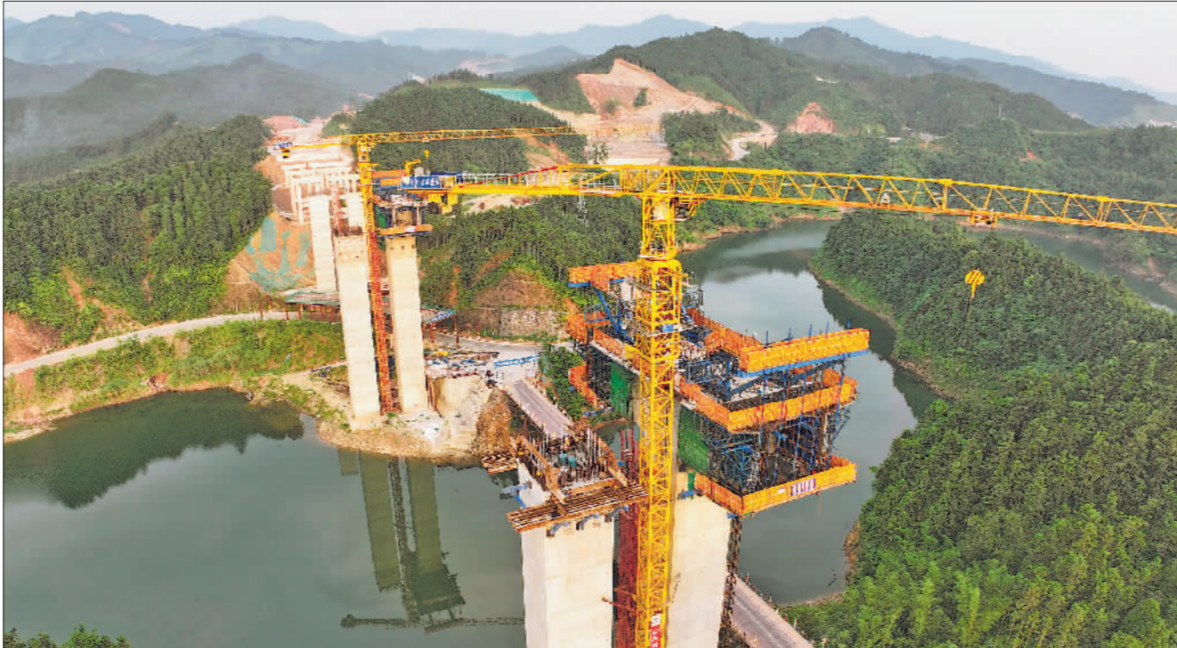
8月3日傍晚，融安至从江高速公路一期工程融水段，工人在桥墩上施工。连日来，位于广西柳州市融水苗族自治县境内的融安至从江高速公路一期工程建设现场，户外高空建设者采取错时施工，避开高温推进建设。新华社发（黎寒池摄）
